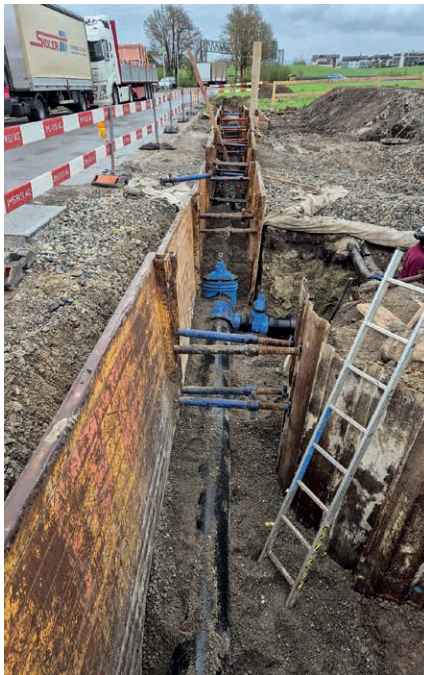
T-Stück mit Streckenschieber auf der Hauptleitung
